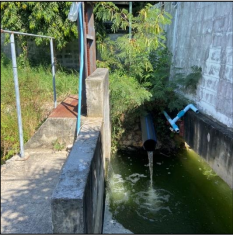
บ่อพักน้ำทิ้งก่อนระบายออกนอกพื้นที่โครงการ
